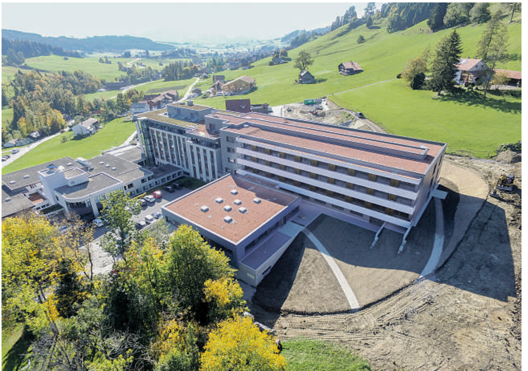
Hinter den bestehenden Gebäuden der Klinik Gais AG wurde in den Hang hinein ein dreiflügliger Anbau erstellt. Er bietet unter anderem Platz für 85 neue Betten. (Bild: zVg)
